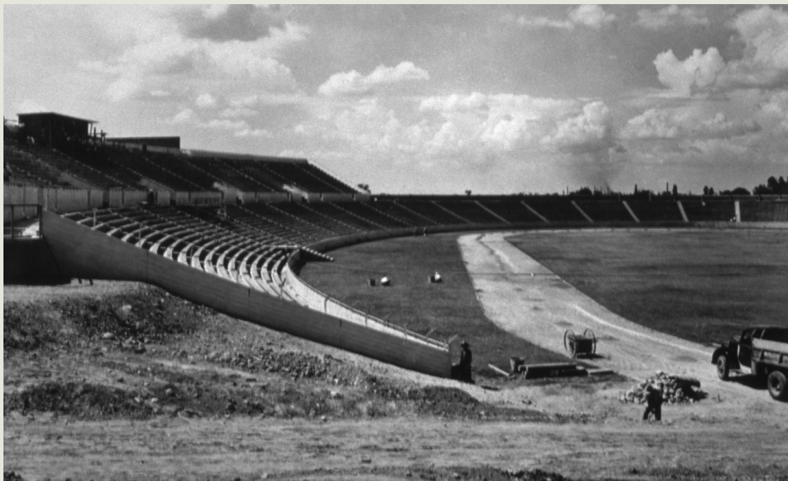
▲ Fase final de la construcción del Estadio Tecnológico. Vista del lado sur hacia el norte, ca.1950.
