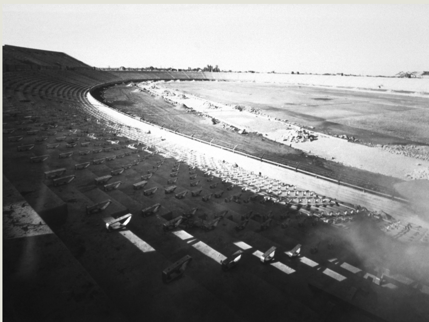
◀ Vista de la tribunas del lado piniente. Se aprecian los soportes donde se colocarían después las gradas de madera. Actualmente esta tribuna cuenta con butacas individuales.
