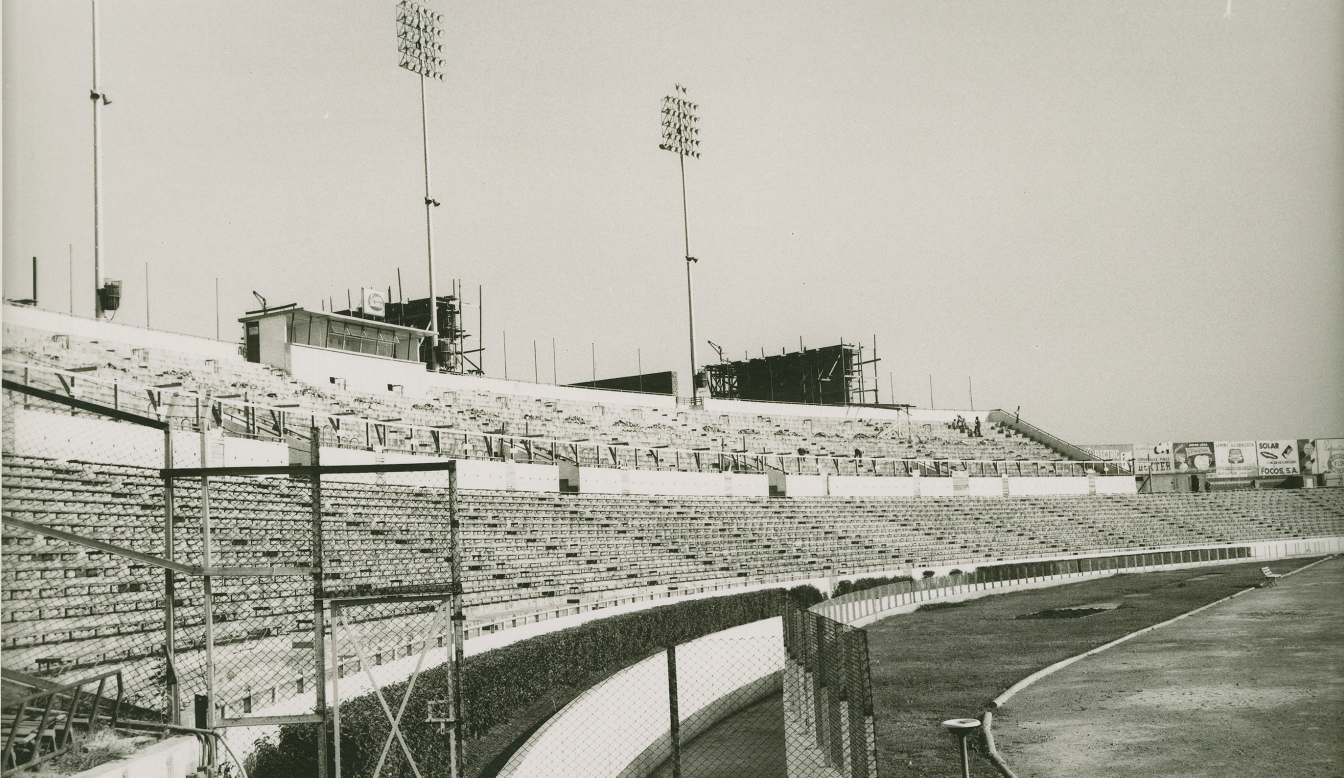
Estadio Tecnológico en la primera etapa de su construcción. El sistema de alumbrado consistía de cuatro torres del lado oriente y cuatro del lado poniente, cada uno con treinta y dos lámparas de 1 500 wats.
