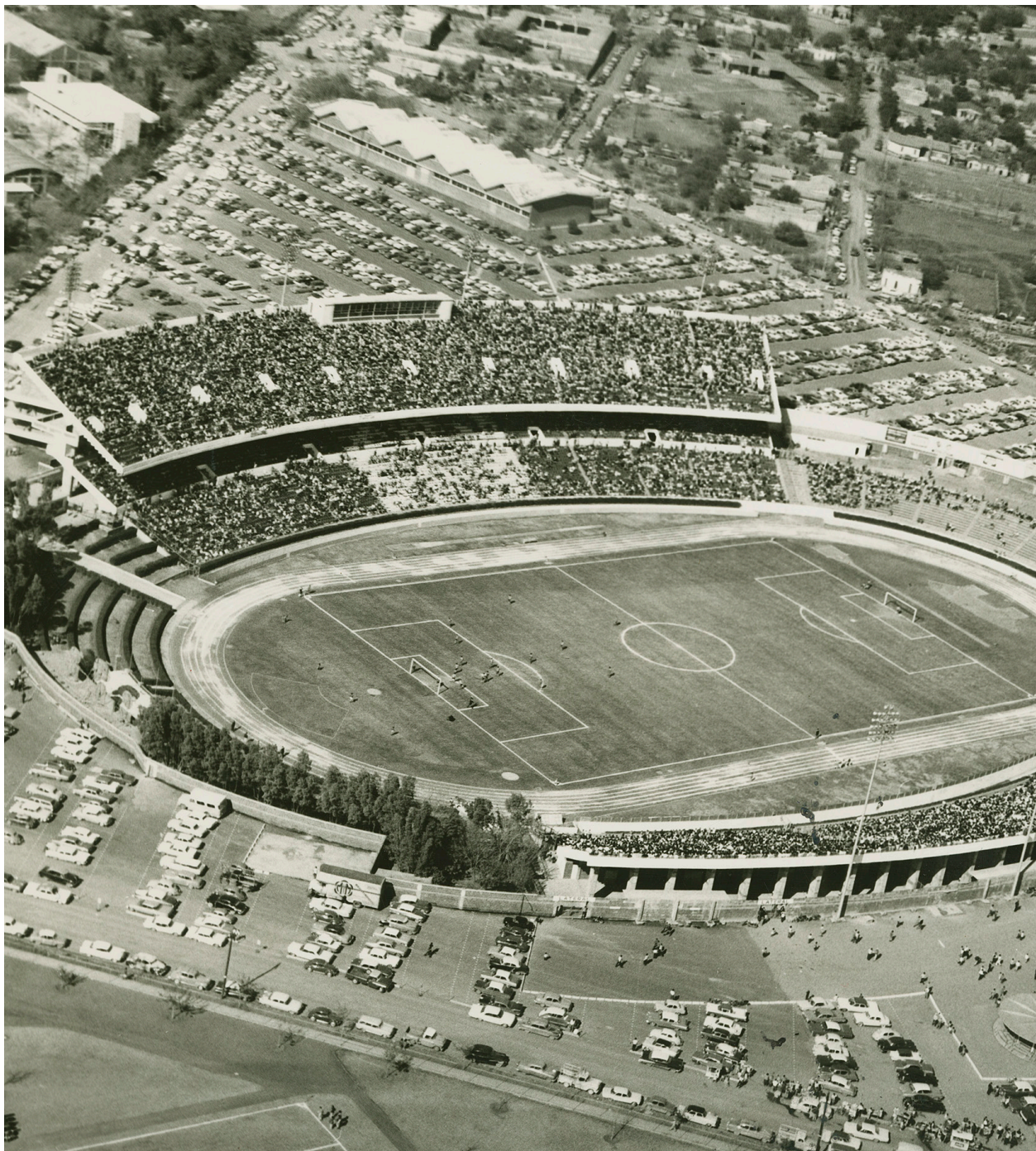
Vista aérea del primer "lleno" del Estadio Tecnológico.
