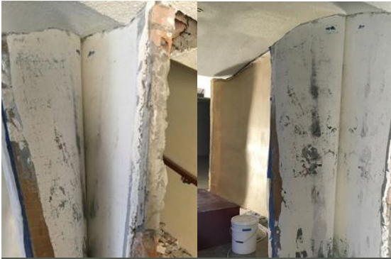
Proceso de retiro del mural y velado, desprendiendo poco a poco del muro.
