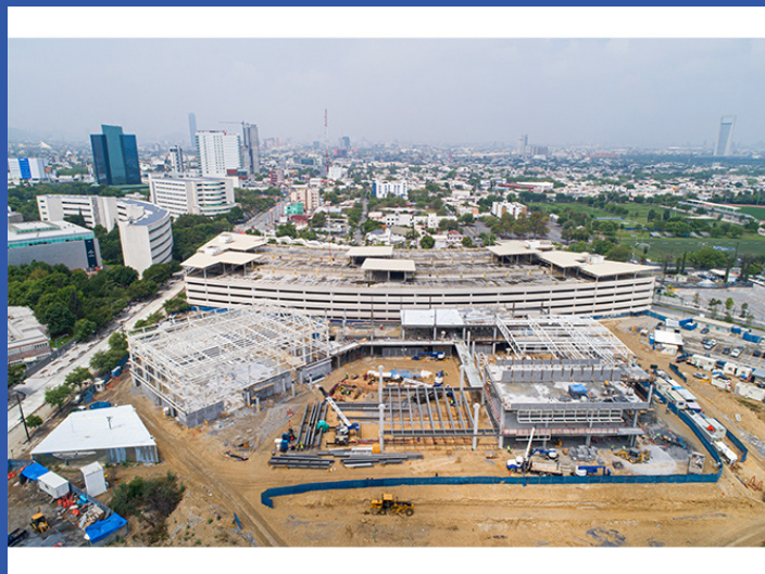
Vista superior frontal en Construcción
